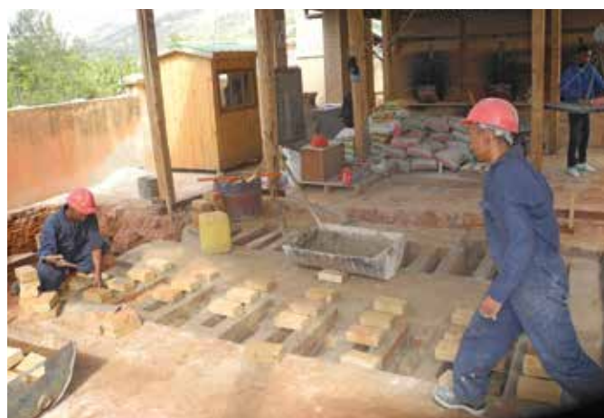
Die Grundsteine für den neuen Brennofen sind bereits gelegt
